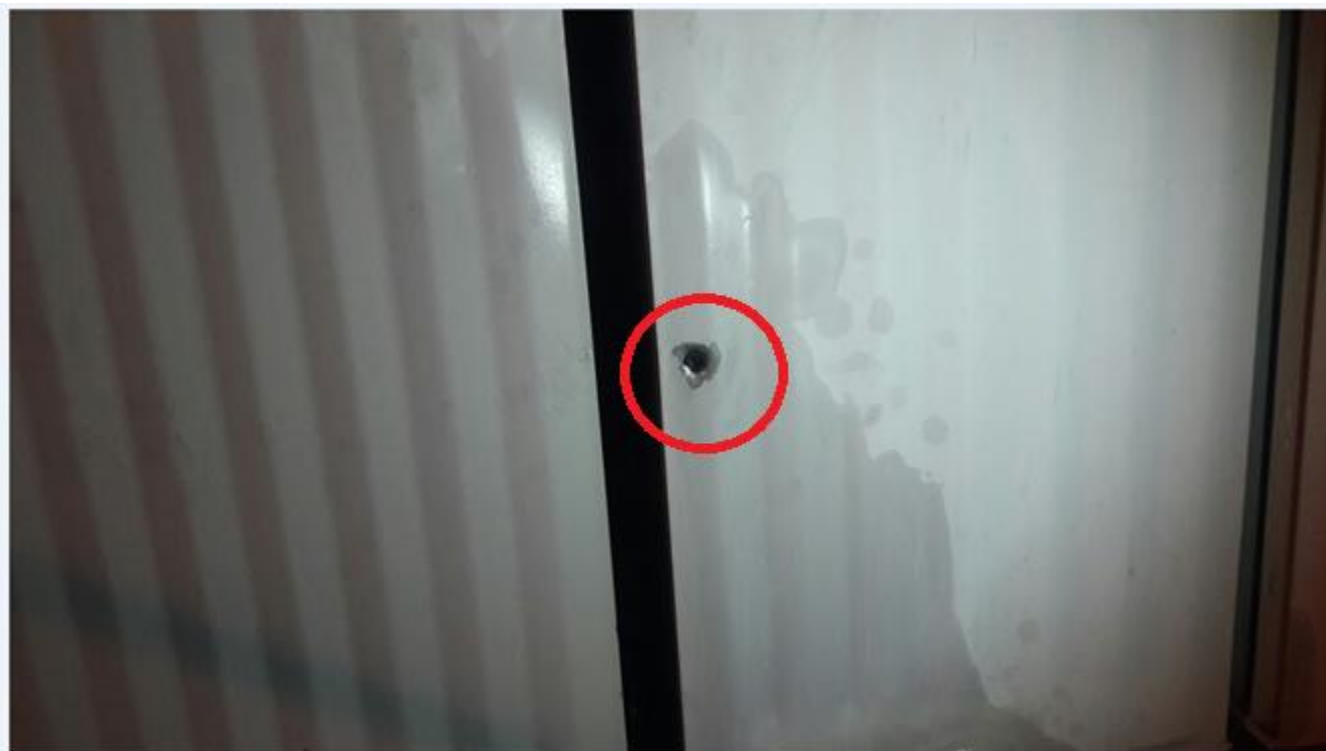
Figura 6 – Perfuração no radiador do transformador
