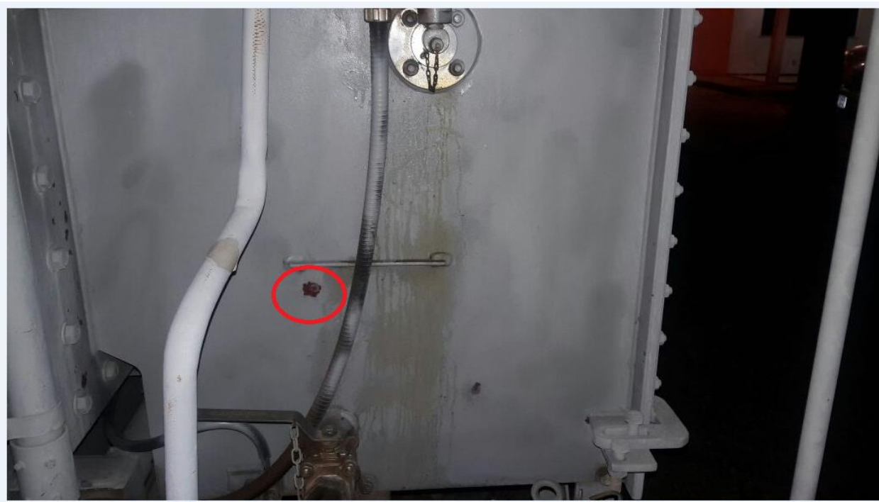
Figura 7 – Marca do impacto do projétil na carcaça do equipamento
